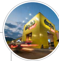
Almacén EXITO, Kra. 51B 2004
