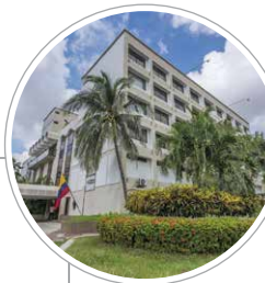
Hotel Puerta Del Sol 1980
